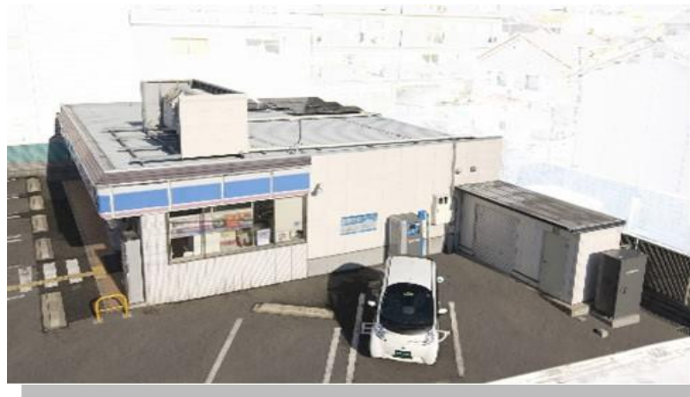
太陽能電池、鋰電池及快速充電機相結合的快速充電系統 “PV-EV系統”。
